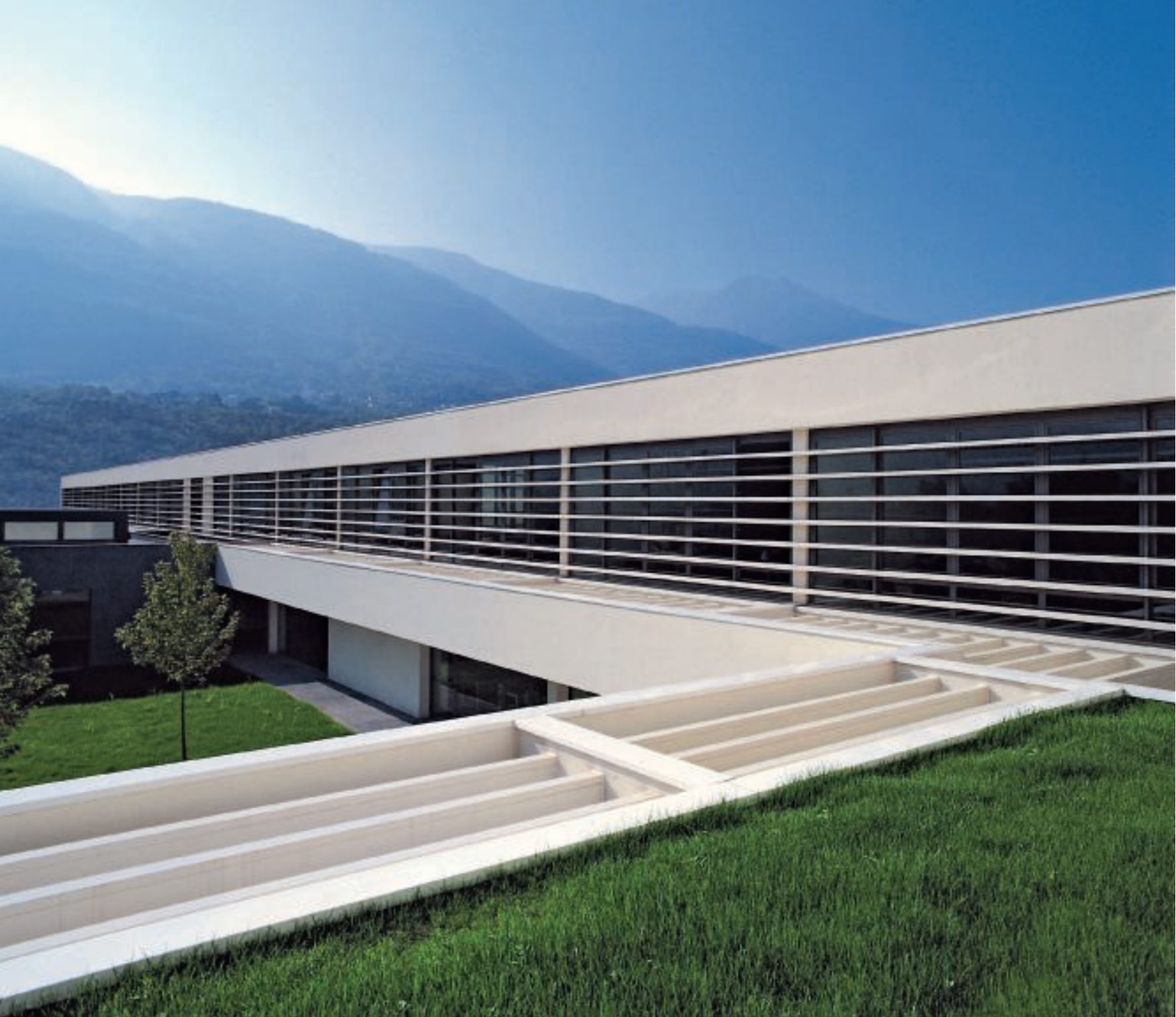
Scorcio del fronte est con i frangisole orizzontali
